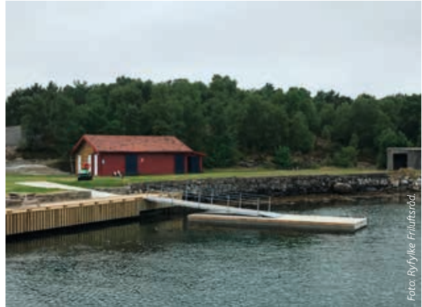
En solid, men likevel relativt enkel brygge som bidrar til god sammenheng mellom tilgjengelighet til friluftslivsområdet både fra sjø og land. Med stoppkant på bryggen kan rullestolbrukere trygt oppholde seg her.
