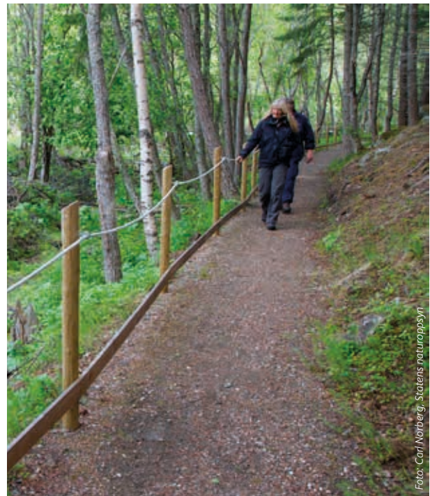
En flat, jevn trase med ledelinjer gjør denne stien godt tilgjengelig både for synshemmede og bevegelsehemmede. For dem med blindestokk er kanten nederst et godt hjelpemiddel. Andre vil foretrekke å følge snoren.
