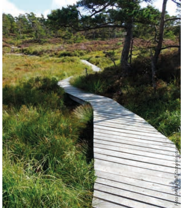
En klopplagt sti som følger terrenget ivaretar variasjon og opplevelse samtidig som slitasje på terrenget minimeres.
