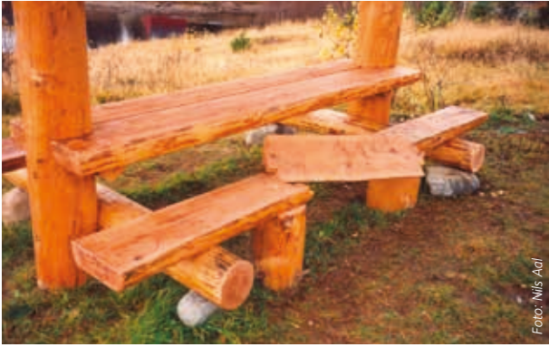
Denne konstruksjonen som Statskog har utviklet gjør at bevegelseshemmede lett kommer inn til bordet.
