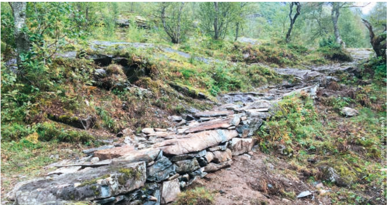
Den gamle ferdselsveien går i slak stigning i tørt terreng. Den er lett å følge og enkel å vedlikeholde.
