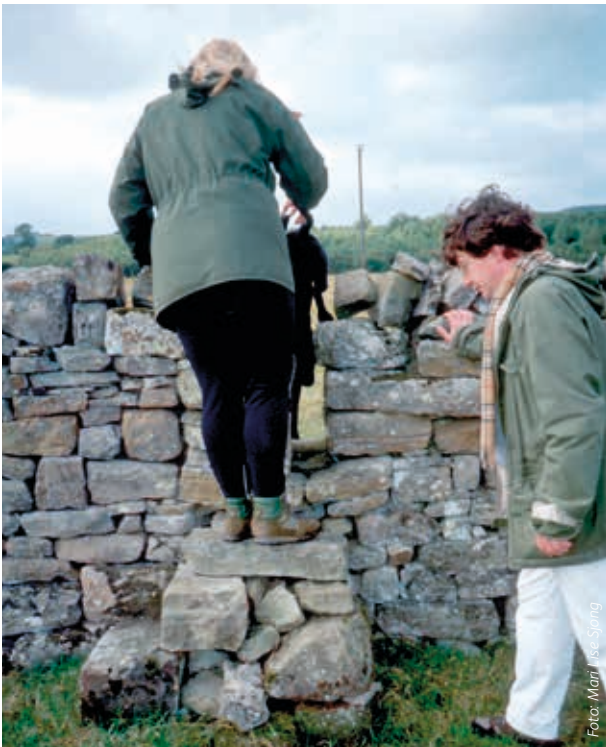
Gjerdeklyv kan utformes på mange måter som f.eks. med trapp over steingjerde
