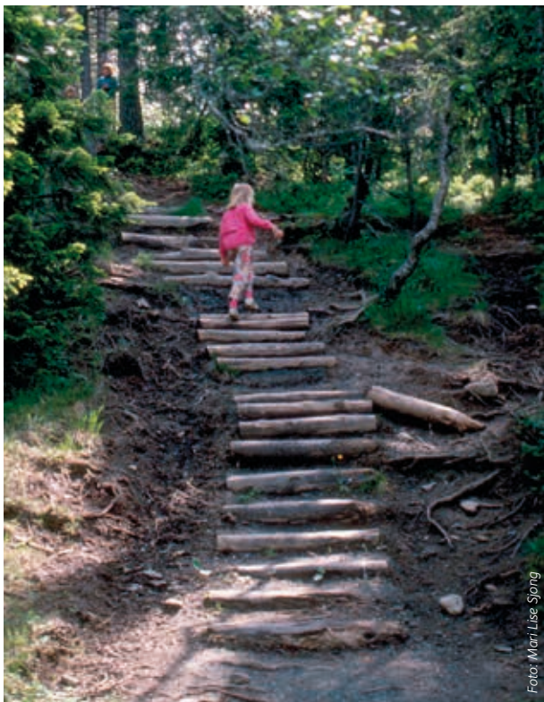
Stokker som forankres i bakken kan være en god løsning for å hindre erosjon og øke tilgjengeligheten i bratt terreng. Trappen/stokkene må jevnlig vedlikeholdes for å hindre utglidning og at stien utvides ved at folk begynner å gå utenom trappen.
