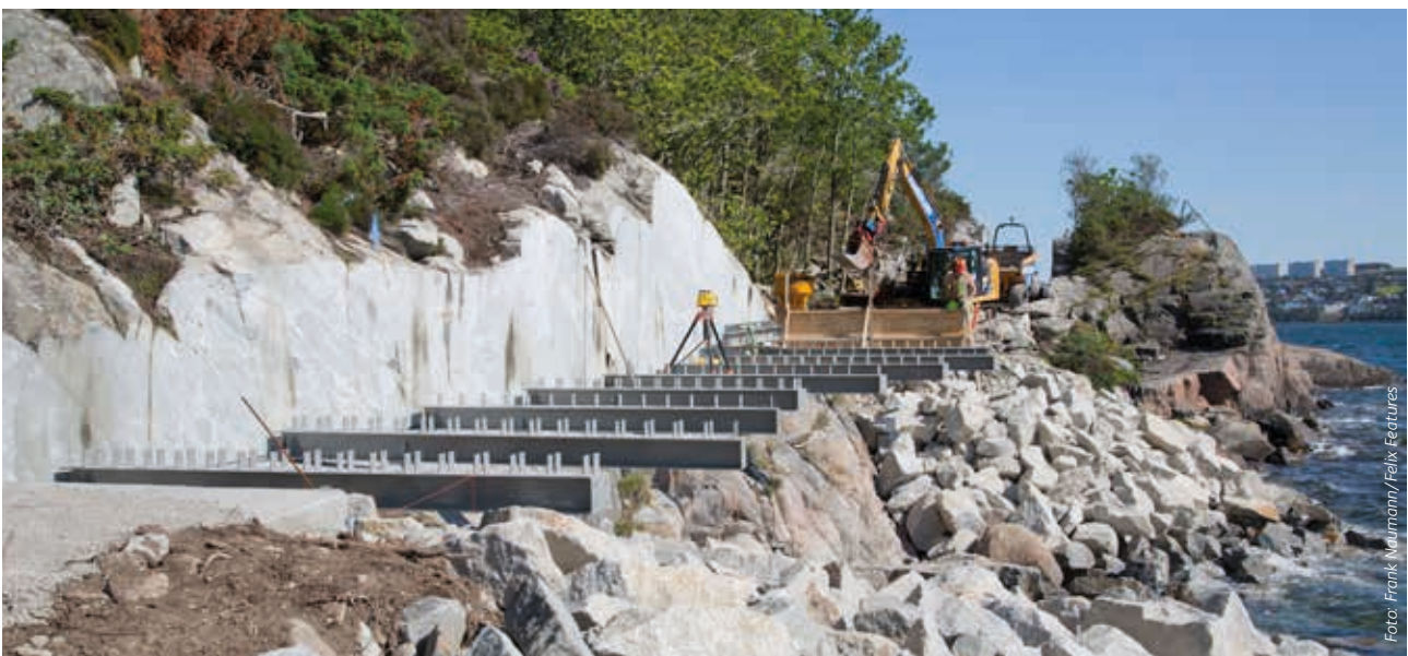
Store maskiner og omfattende tilrettelegging bør primært unngås, men er noen ganger nødvendig. Det kan være i urbane strøk, i områder med stor ferdsel og/eller for å kunne passere bratte partier der det ikke finnes gode alternative trasevalg.
